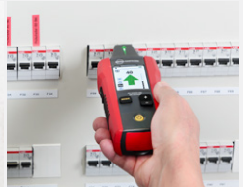
Zuordnung des richtigen Leitungsschutzschalters/Sicherung
