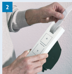
2 Gurtband einziehen und befestigen
