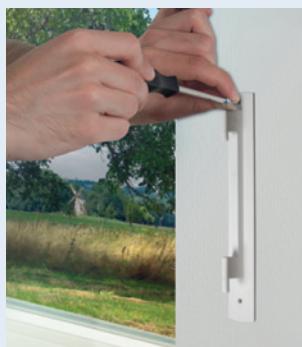
Wandhalterung montieren
