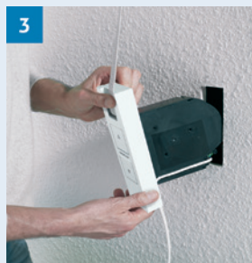
3 RolloTron einbauen
