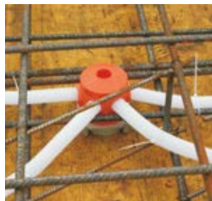
Beispiel für Montage in waagrechtter Schalung.
