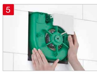
Im Zuge der finalen Arbeiten im Raum wird der Ventilatoreinsatz einfach eingeschoben und rastet hörbar ein.
