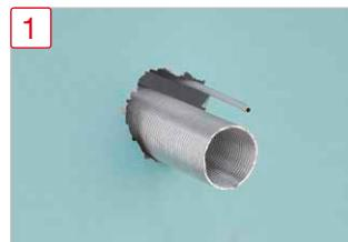
Abluftleitung und Netzanschluss werden an der späteren Montageposition von ELS platziert.
