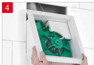
Das Unterputz-Gehäuse kann nun mit vormontiertem Vorwandadapter und Ventilatoreinsatz ganz einfach mit der Netzleitung verbunden werden. Anschließend wird es in die fertige Wand eingeschoben.
